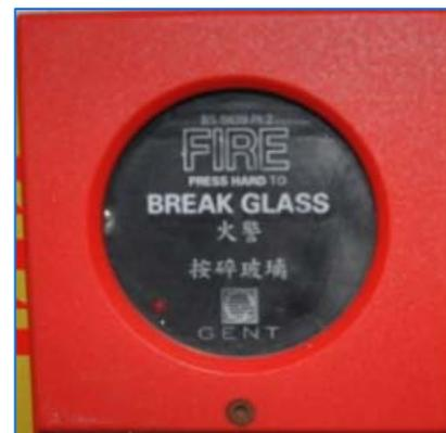
火灾时打破破玻，会自动报警同时启动消防水泵。
