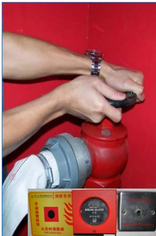
5、逆时针方向打开阀门，喷水灭火。
