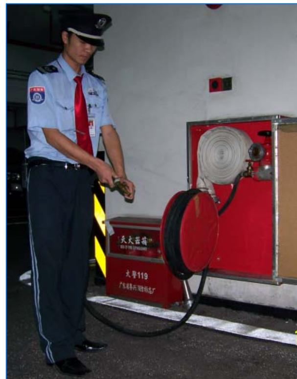
6、火势较小的情况下可用卷盘水枪，打开后端阀门，将水带拉到着火点打开前端水阀即可灭火。
